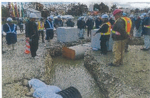
3種類の現場を想定した打設状況
