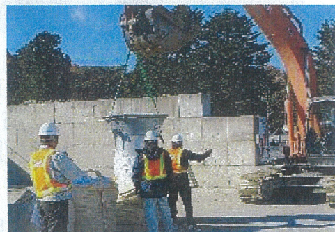
大型土のう製作
