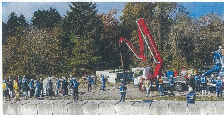
ポンプ圧送車による流動化処理土の打設
