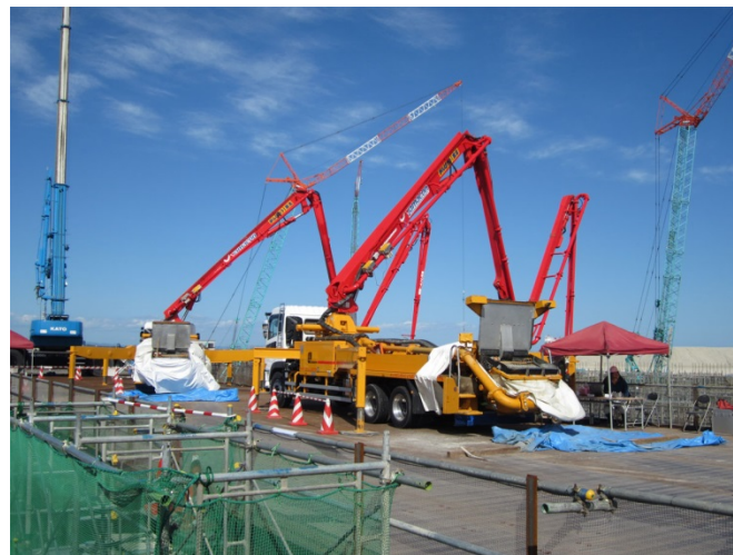
南蒲生浄化センター
