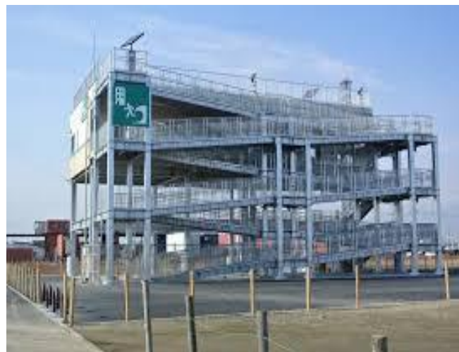
仙台市・白鳥防災非難タワー
