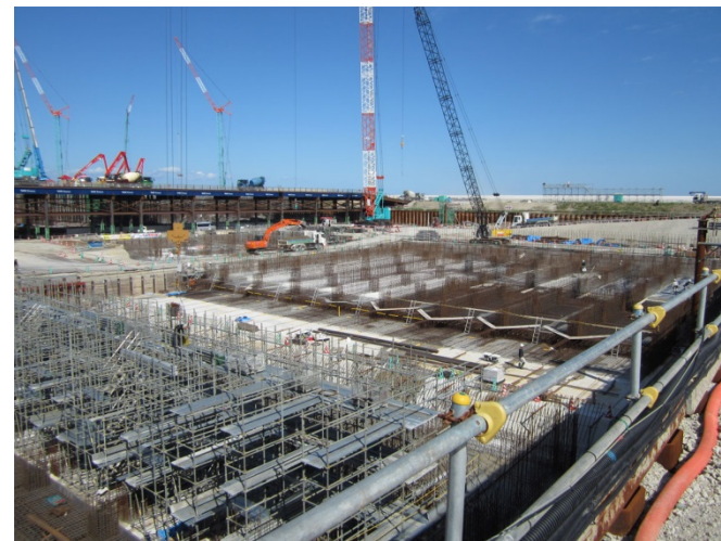
南蒲生浄化センター
